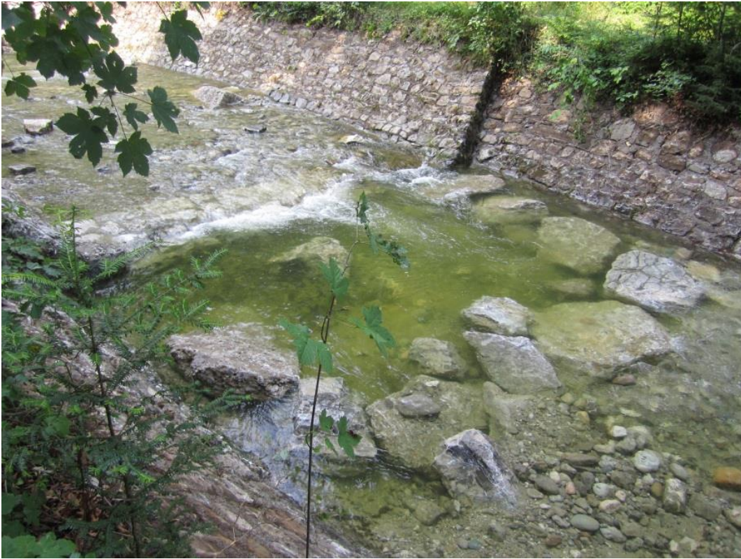
Bild: Umgebaute Schwelle mit anschließendem tieferen Becken für Fische
